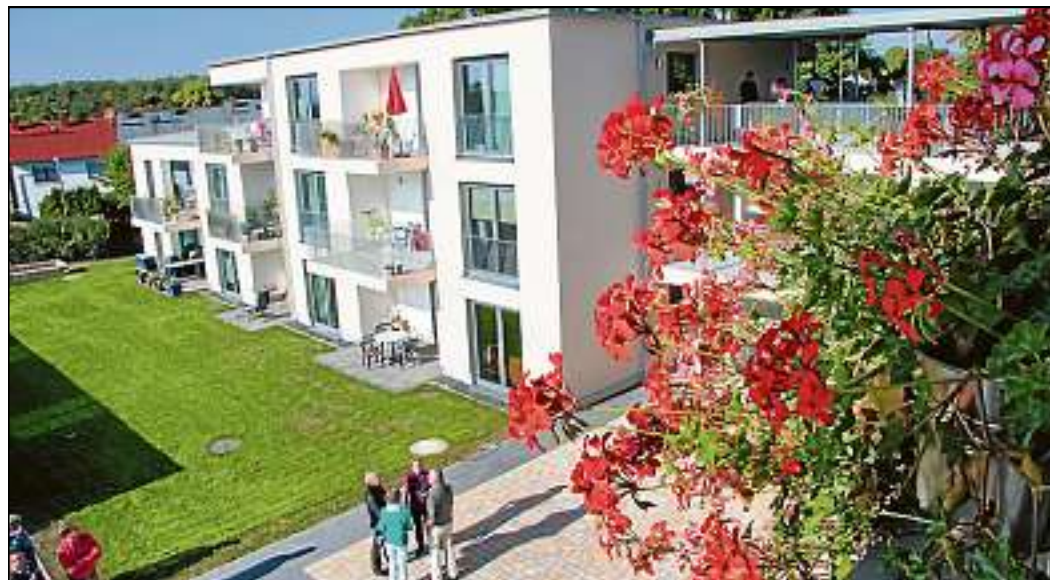
1250 Quadratmeter Fläche wurden auf 19 Wohnungen sowie einen Gemeinschaftsraum verteilt – barrierefrei. Alle Wohnungen können durch Laubengänge und einen Aufzug erreicht werden.
